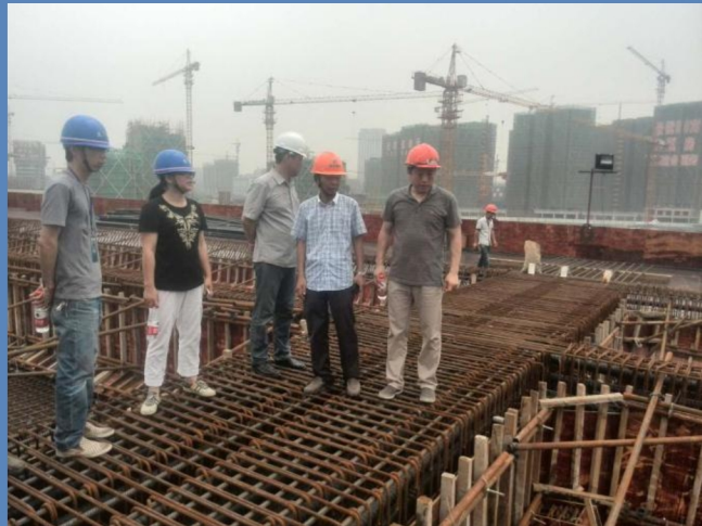
建设单位箱梁钢筋验收
